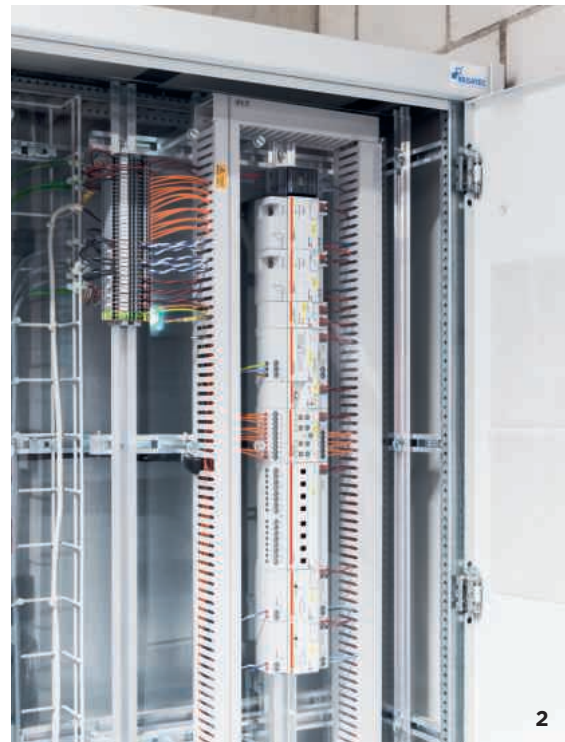
1 Au cœur des bureaux et au cœur du studio: Tolga De Peri, Roger Pierson et Didier Perret dans le futur studio de SRF Sport | 2 Technologie KNX éprouvée pour la commande de l'éclairage et des stores, incluant des appareils modulaires pour l'alimentation du bus
